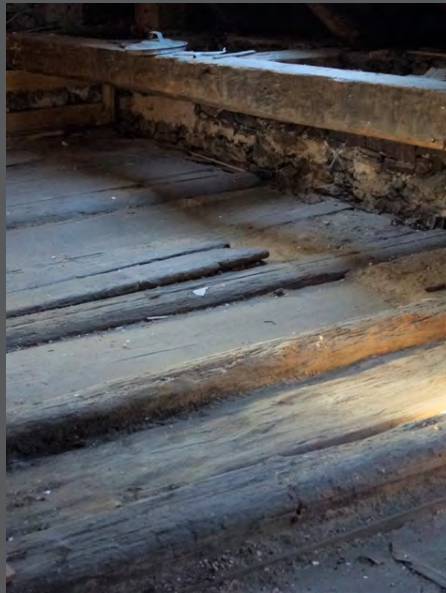
Südlicher Hausbereich, Dachgeschoß, sog. "Bal- ken-Bohlen-Decke" und rechts im Bild-Dach- stuhlkonstruktion des ausgehenden 15. / 16. Jahrhundert
