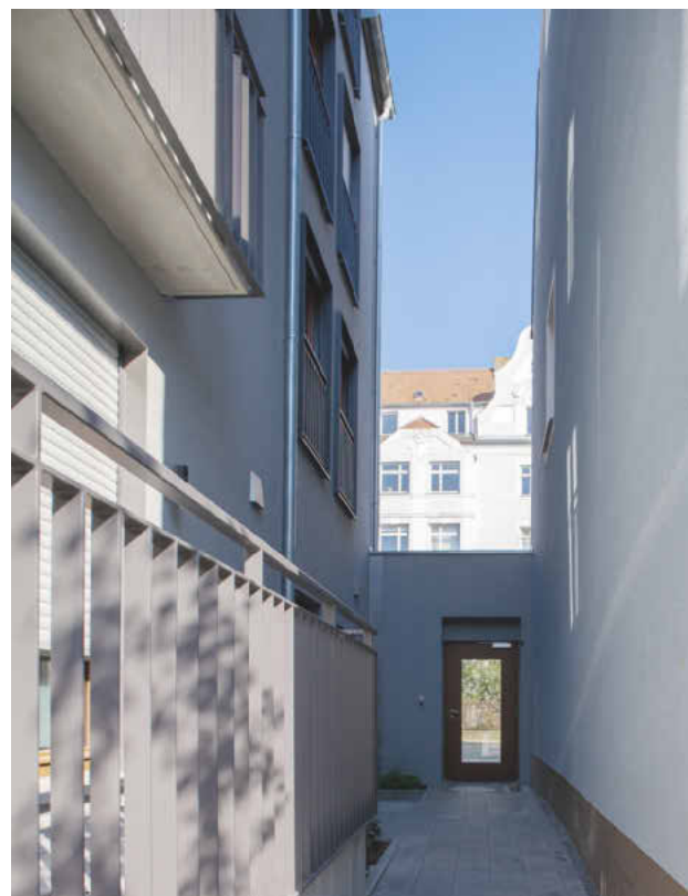
Auf dem schmalen Grundstück führt ein schmaler Weg zum Hof, um die Wohnungen zu erschließen.
