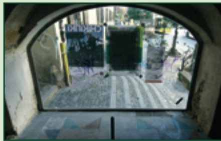
Blick durch den Renaissance-Bogen im EG der Gewerbeeinheit auf den Fischmarkt
